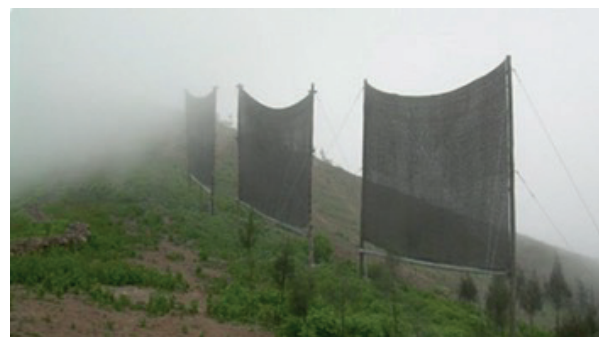
Figura 7. Banco de colectores de niebla [14].
