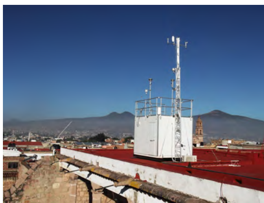
Figura 1. Estación de monitoreo atmosférico de Morelia, Michoacán. Ubicada en la azotea de Palacio Municipal.
