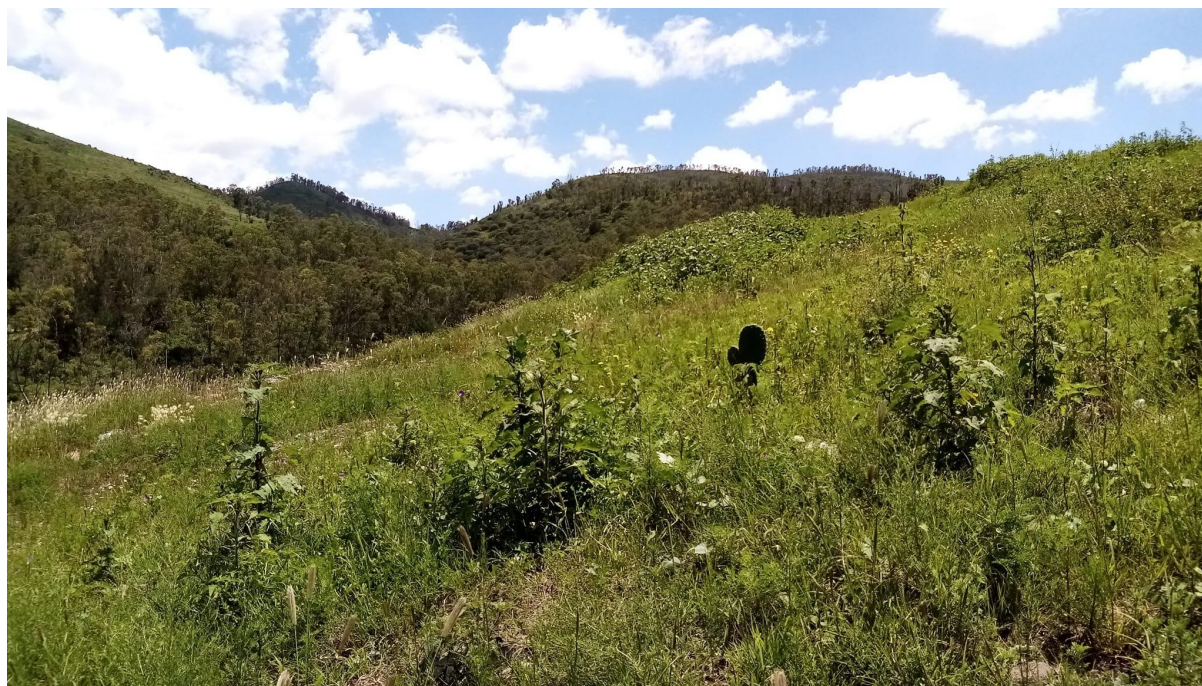
Figura 3: Exvertedero de la Sierra de Guadalupe a cielo abierto en el municipio de Tultitlán. En primer plano se aprecia un enorme montículo de residuos sólidos municipales, totalmente cubierto por vegetación herbácea. Este gran montículo está rodeado por un canal que concentra y por donde fluyen los lixiviados.
